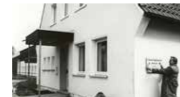
Umbau am Gutshof Wiggginghausen
